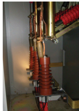
Sensor de tensão de 24 kV instalado em aplicação de switchgear de distribuição
